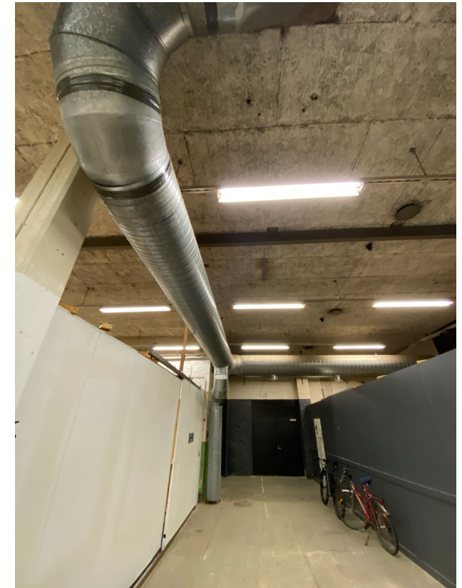
Kuva 28. Eteläosan hallia on jaettu osiin keveillä väliseinillä.
